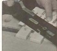
Wenn der Leim ausgehärtet ist, Dübel bündigsägen, restliche Anrisse und Dübelreste wegschleifen.
